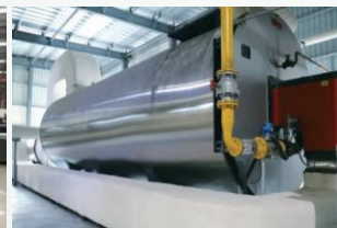
生物质锅炉改天然气锅炉
